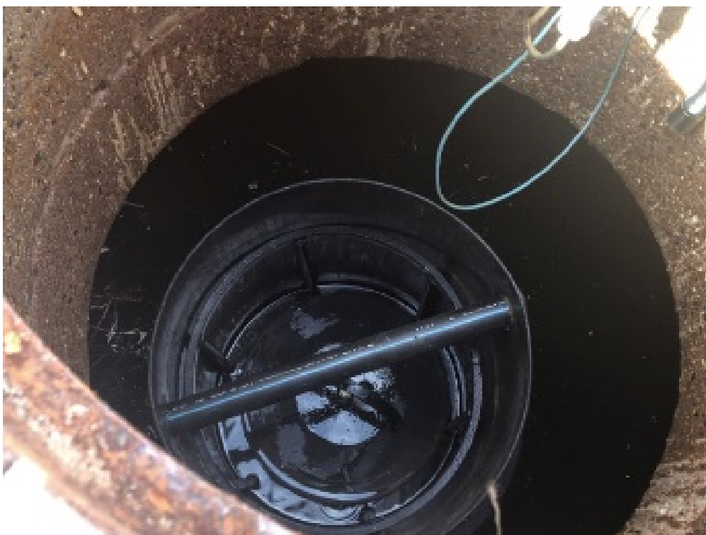
Foto: Controle op drijfvermogen vlotter
