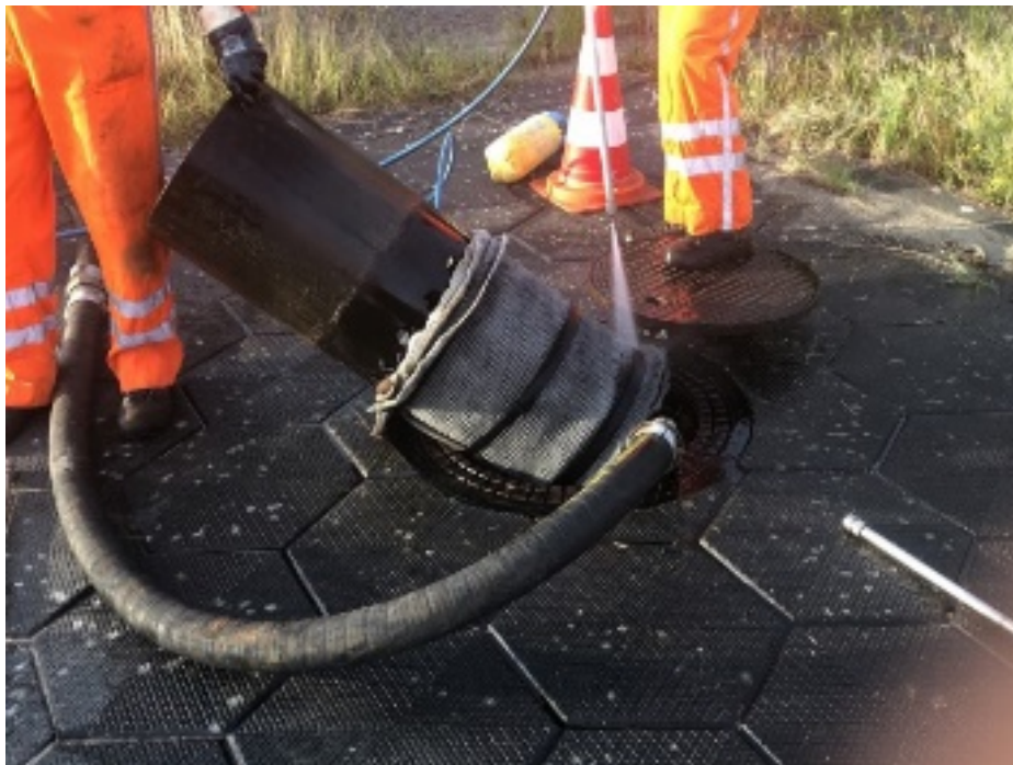
Foto: Controle ingebouwde onderdelen
