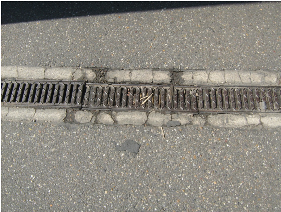
Foto: Aansluiting op lijngoot.
